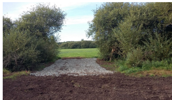
Aménagement de 3 passages à gué entre les parcelles en sept. 2021
